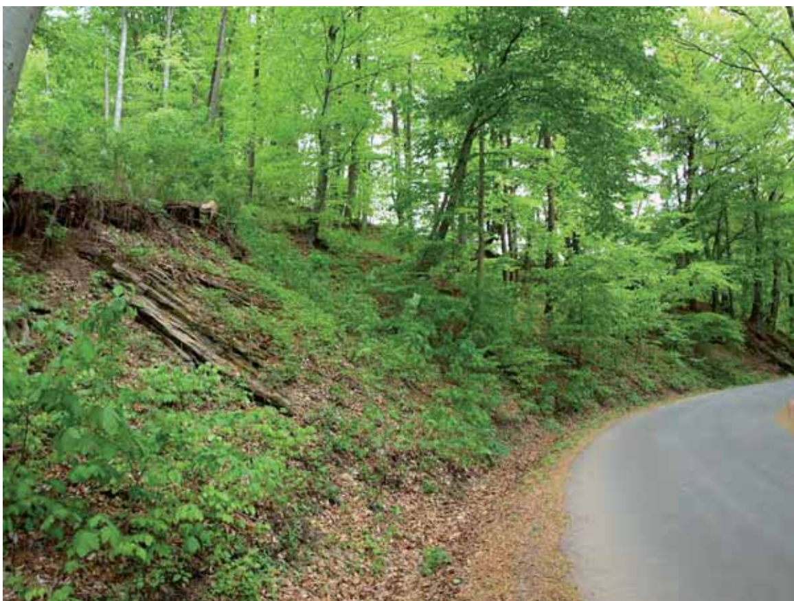
Pravá strana silnice – 270Cf8
