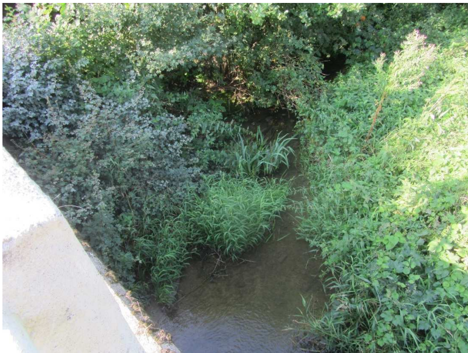
Foto č. 4 Pohled na charakter koryta pod mostem na Tikov
