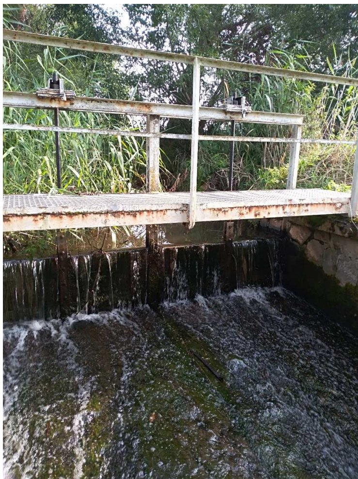
Foto č. 7 – Jez Popovice (ř. km 25,55)
