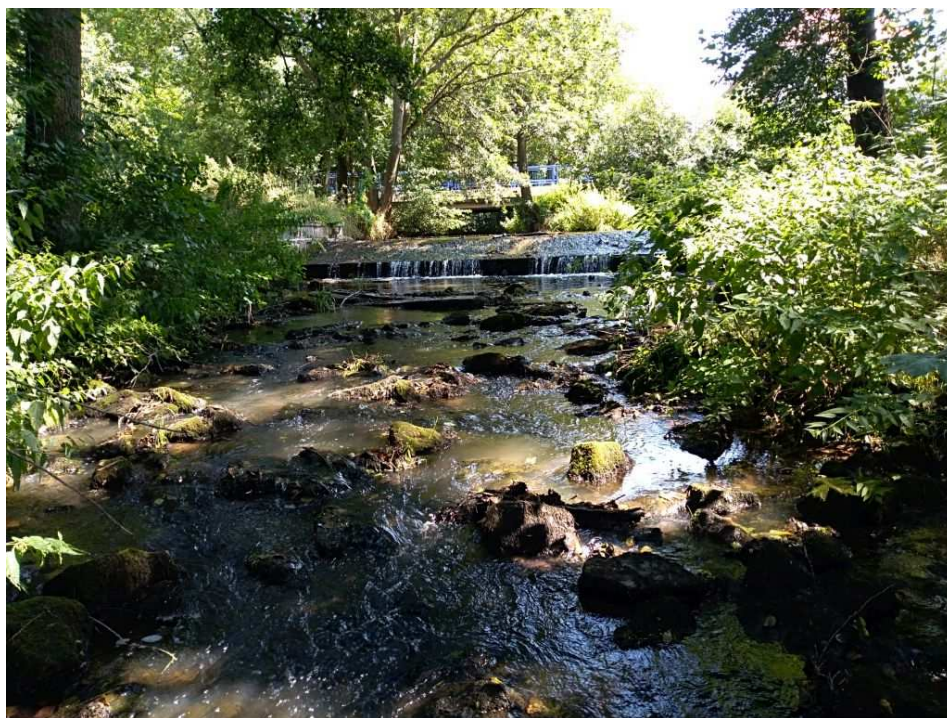
Foto č. 6 – Jez Dohalice (ř. km 29,57)
