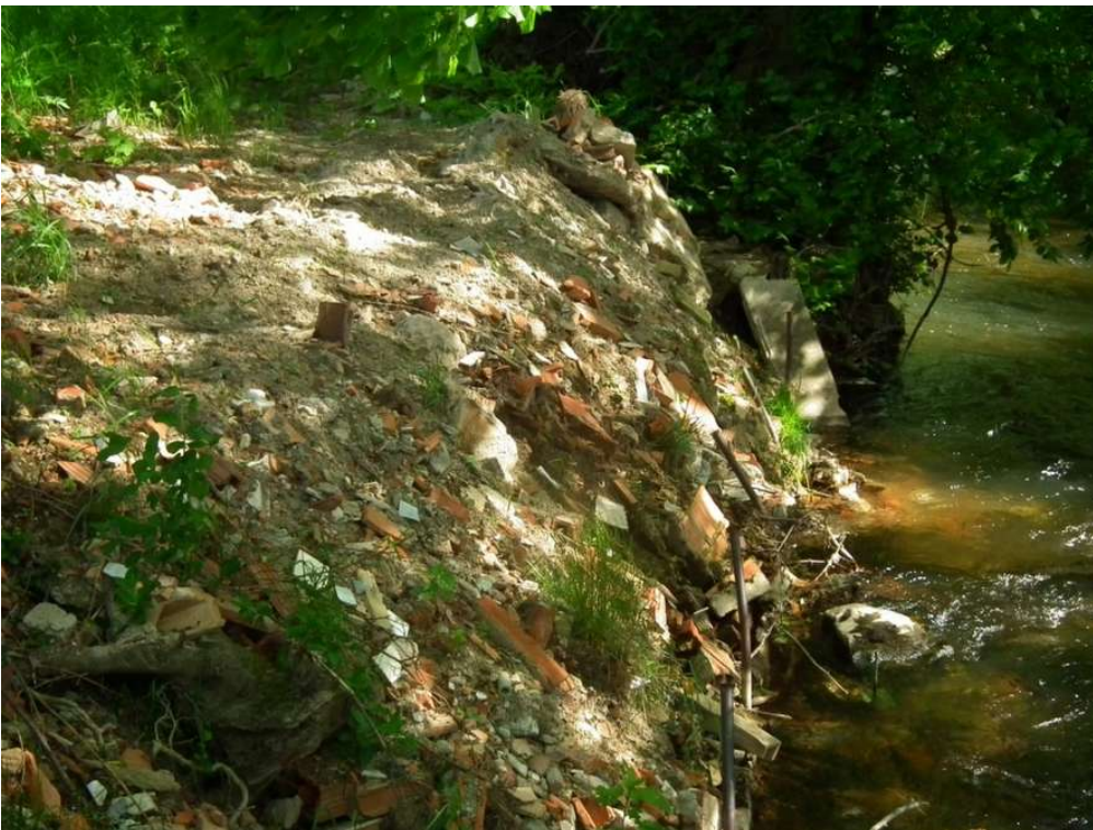
Obr. 6. Břehové pásmo zahrnuto stavební suti až do řeky nedaleko příměstského tábora v Mělčanech. (foceno 17. 5. 2013. F. Laštovic)
