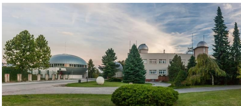
Budova hvězdárny a nového digitálního planetária.
