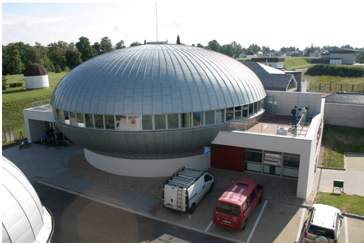
Červen 2014 - Budova planetária měsíc před kolaudací.
