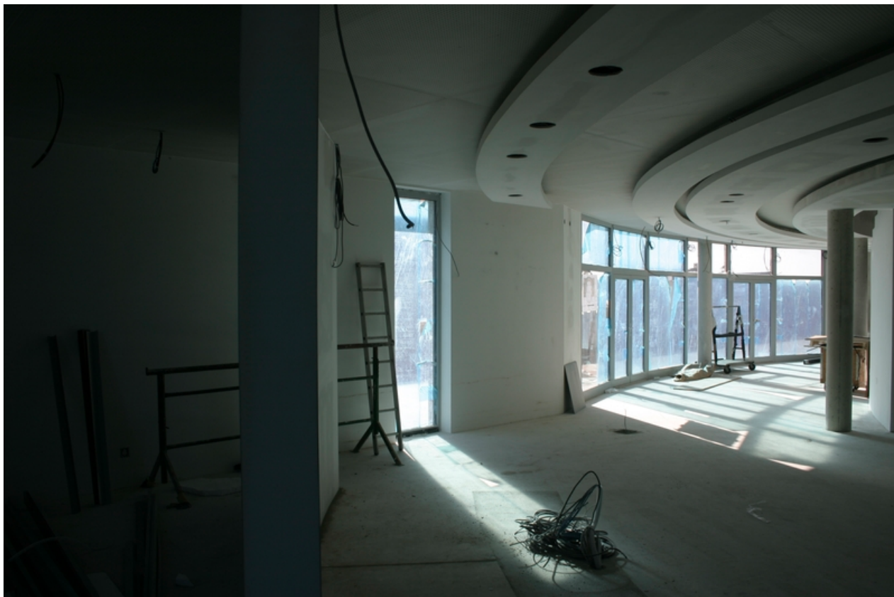
Březen 2014 – dokončovací práce ve foyeru.
