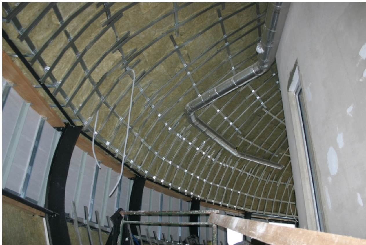
Leden 2014 – druhé nadzemní podlaží – tepelná izolace a kostra vnitřku elipsoidického pláště.
