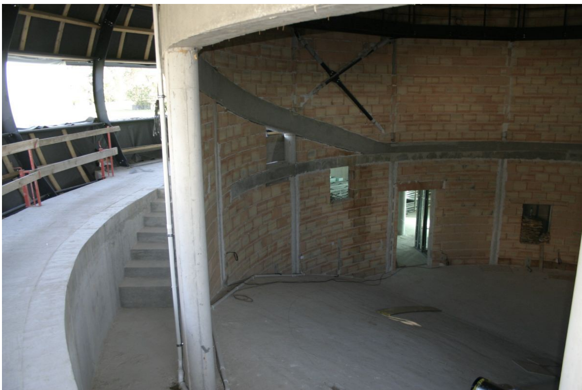
Říjen 2013 – výstavní ochoz ve 2. podlaží a vnitřní kruhový sál s nakloněným hledištěm.
