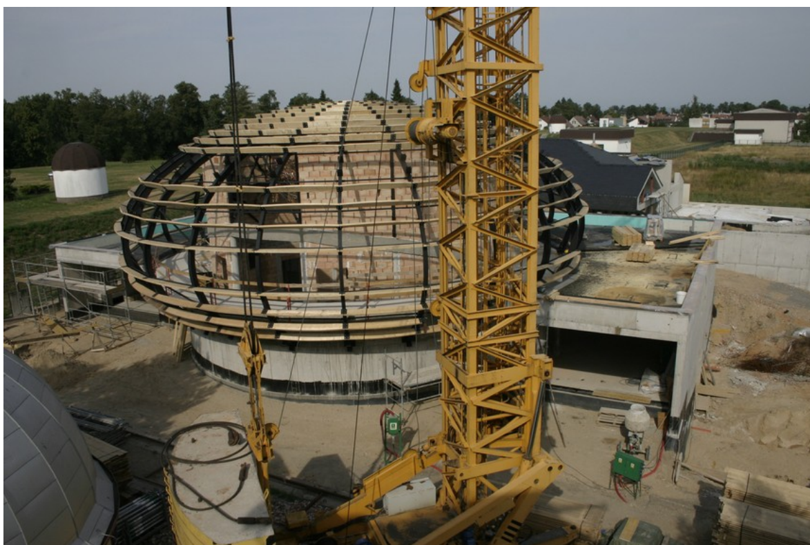
Srpen 2013 – kostra vnějšího pláště ve tvaru rotačního elipsoidu.
