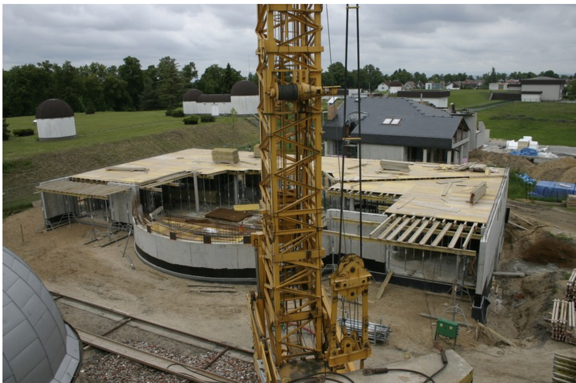
Červen 2013 – zastřešování prvního nadzemního podlaží.
