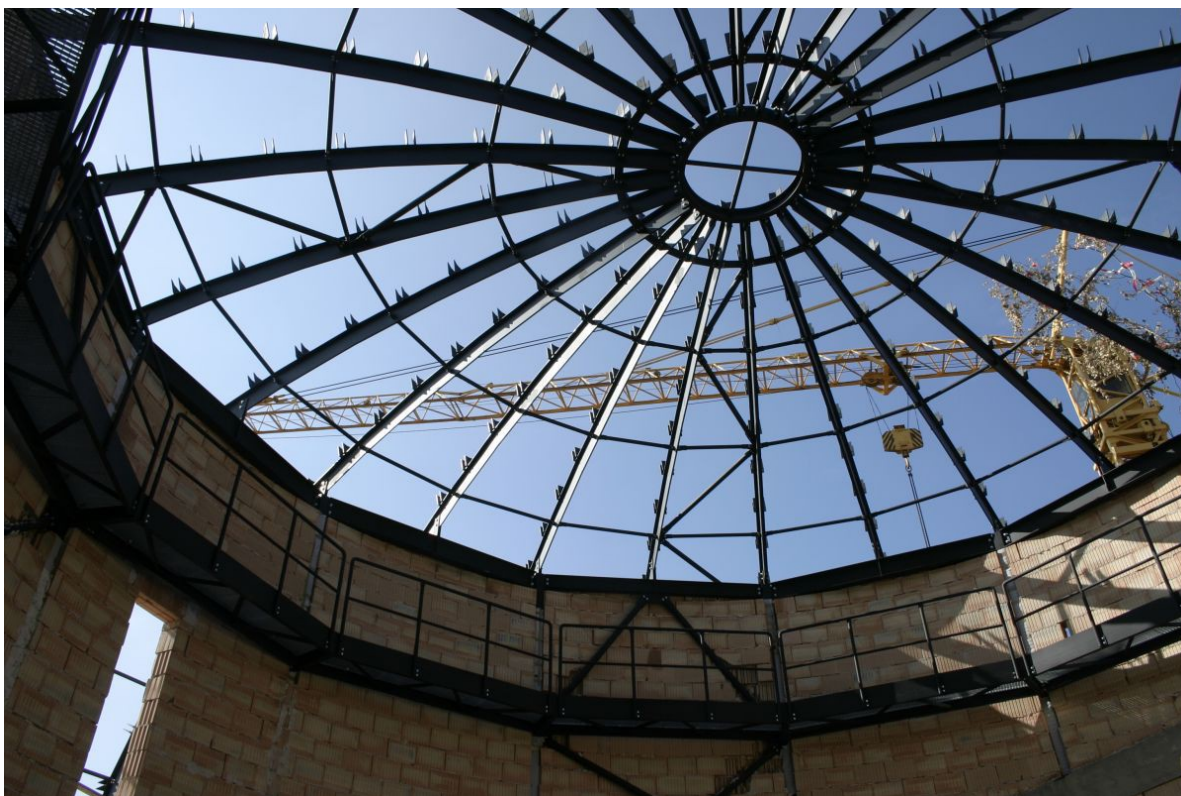
Červenec 2013 – kovová střešní kostra nad kruhovým sálem
