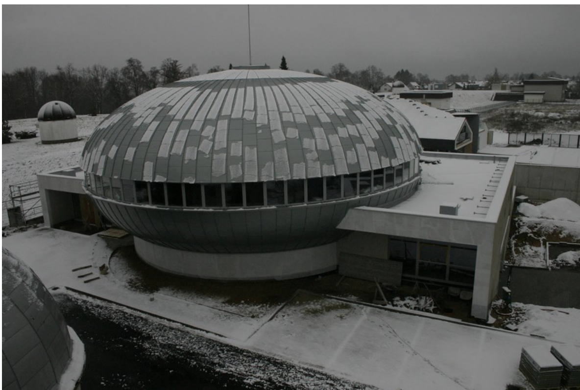
Prosinec 2013 – vnější plášť dokončen, přichází zima, začínají práce v interiéru.
