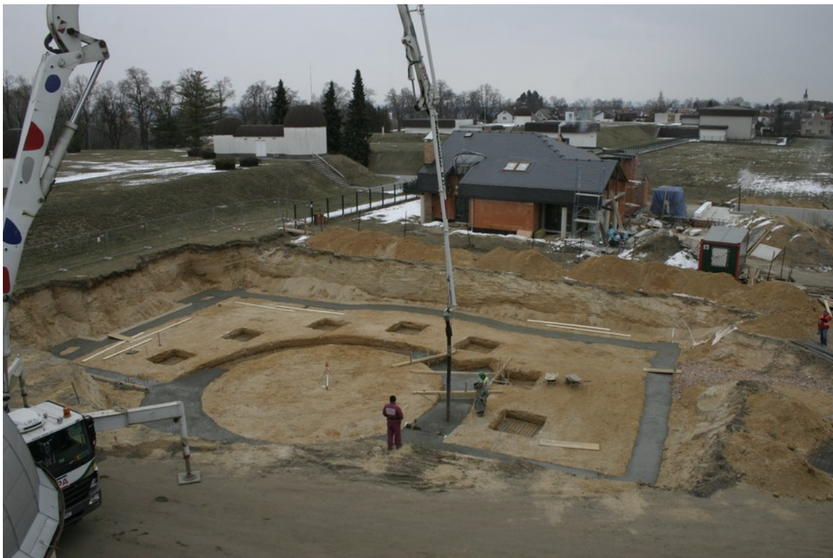
Březen 2013 – zakládání stavby, na okolních pozemcích jsou ještě patrné zbytky sněhu.
