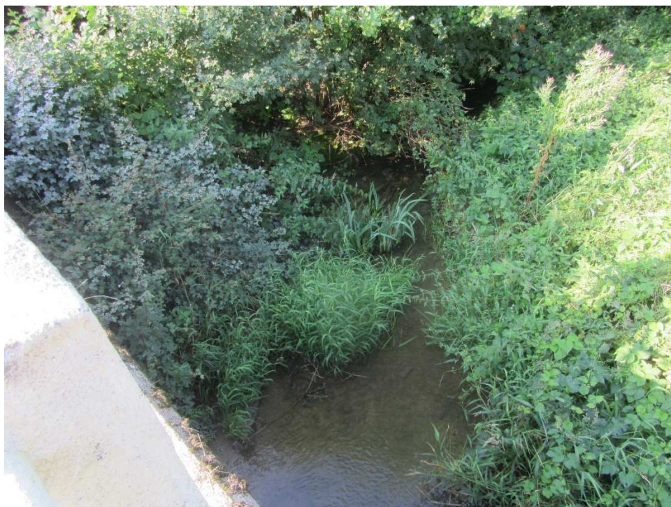
Foto č. 5 – Pohled po proudu z mostu na Tikov. Výskyt raka říčního. Úsek č. 2
