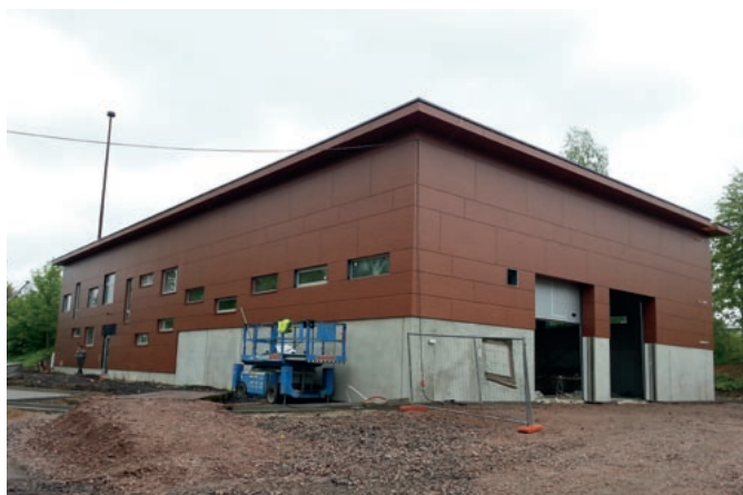
Nová hasičská zbrojnice, přestavěná z kotelny, město Rokytnice v Orlických horách
