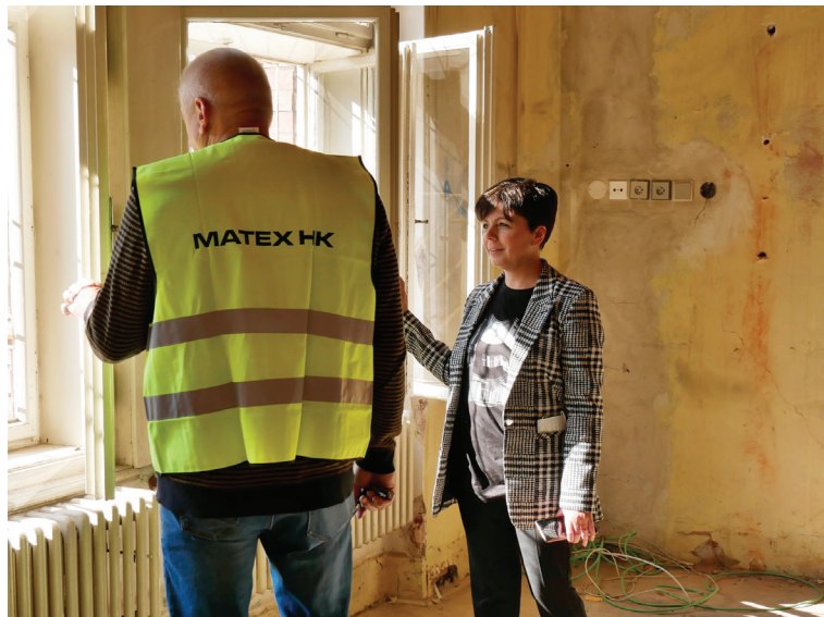
Začátek rekonstrukce vily zkontrolovala náměstkyně Martina Berdychová.
