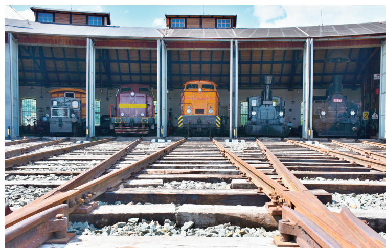
Kousiček od jaroměřského vlakového nádraží leží 110 let stará Výtopna Jaroměř, kterou spolek nadšenců přetvořil na železniční muzeum. Mají tu k vidění staré vagony, dreziny, funkční točnu a především - parní lokomotivy. Díky podpoře ze strany Královéhradeckého kraje se muzeum daří stále rozvíjet, například finanční pomocí na opravu střechy.
