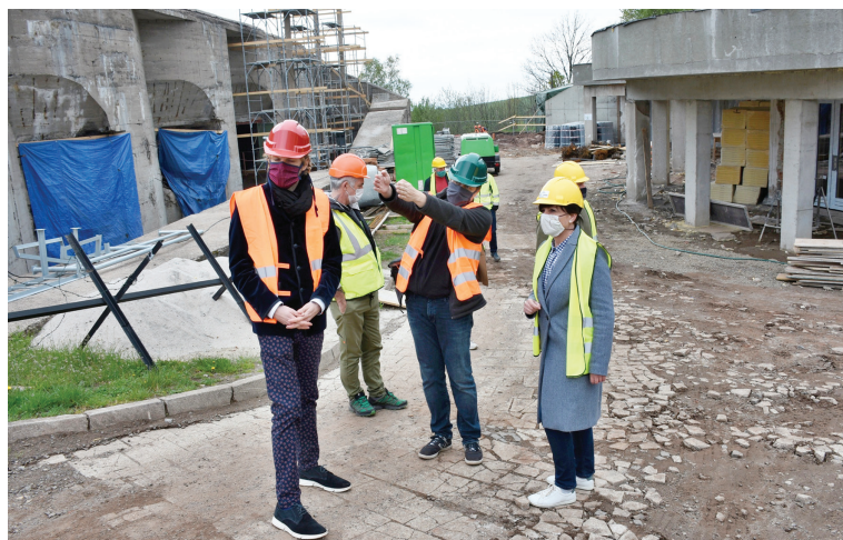
Pevnost Dobrošov se proměnila ve staveniště. Kraj zde za 94 milionů korun vybuduje do příštího roku nové expozice i moderní bezbariérové návštěvnícké centrum se sociálním, technickým a technologickým zázemím pevnosti. Postup prací přijela zkontrolovat náměstkyně pro kulturu Martina Berdychová (na snímku vpravo).
