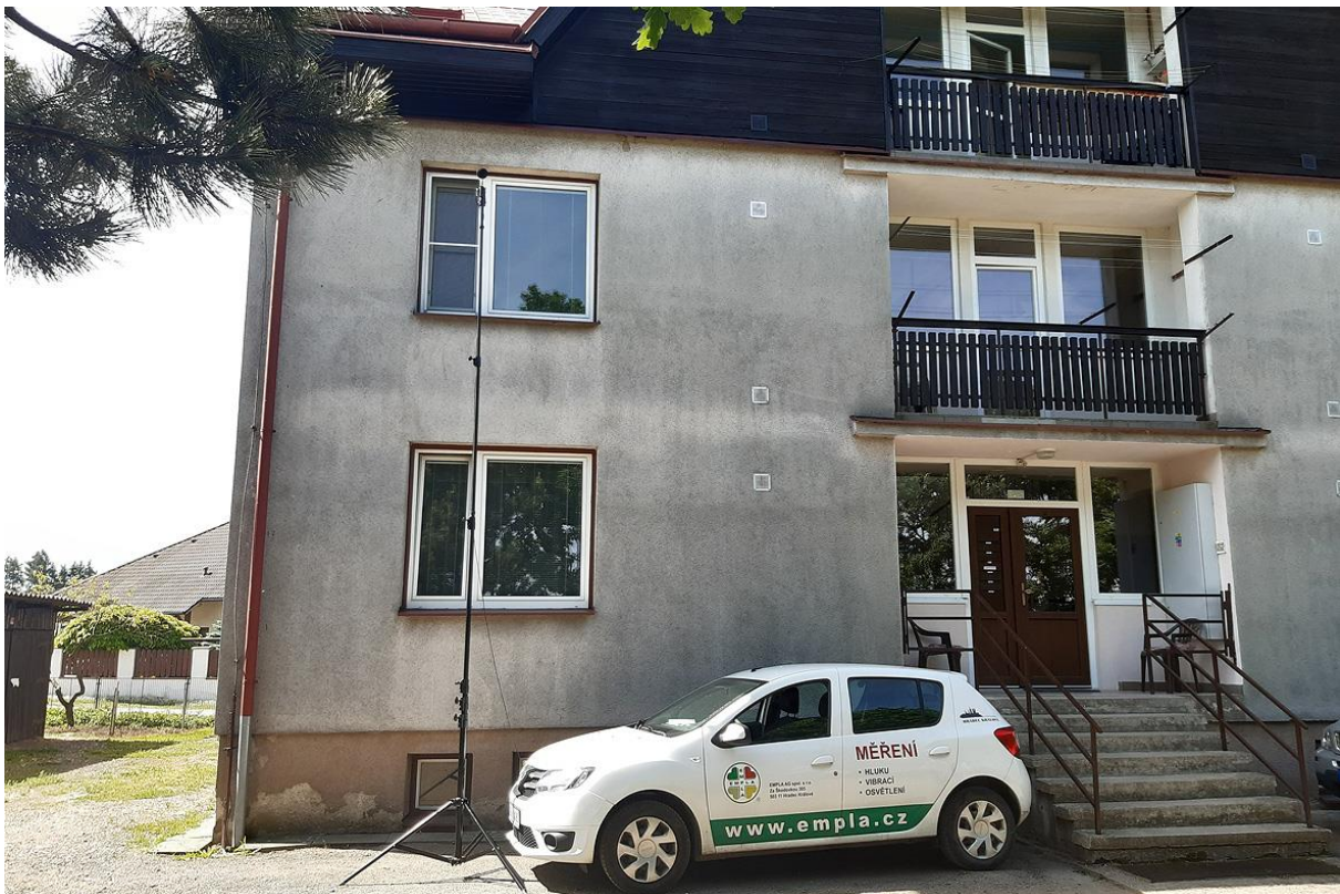
OBR. 5 Pohled na měřicí místo č. 8
