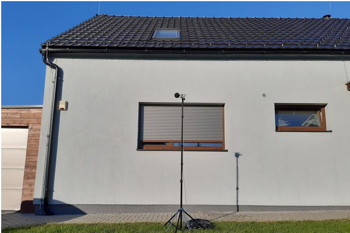
OBR. 7 Pohled na měřicí místo č. 9
