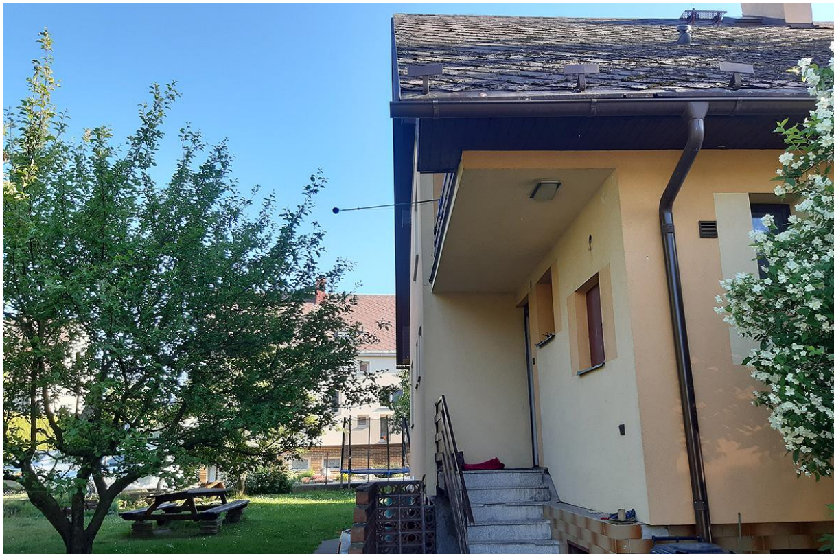
OBR. 3 Pohled na měřicí místo č. 7
