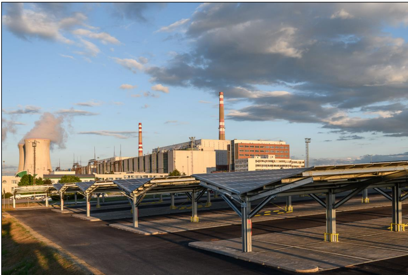
Obrázek 37: FVE Carport Dukovany (Zdroj: EkologickáAuta.cz)
