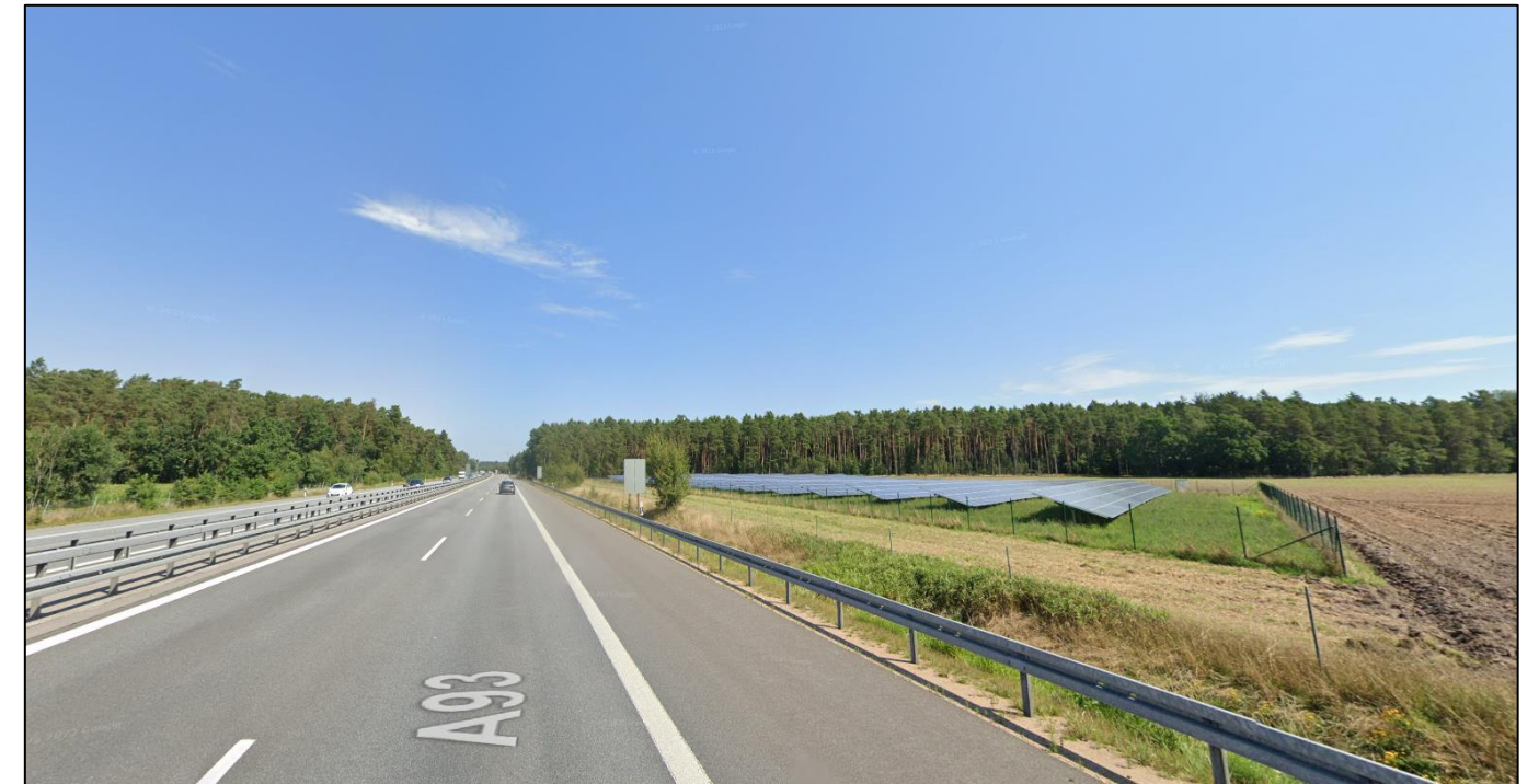
Obrázek 32: FVE situovaná podél oplocené dálnice A93, Německo, Steinberg am See (Zdroj: Google Maps, 2022)
