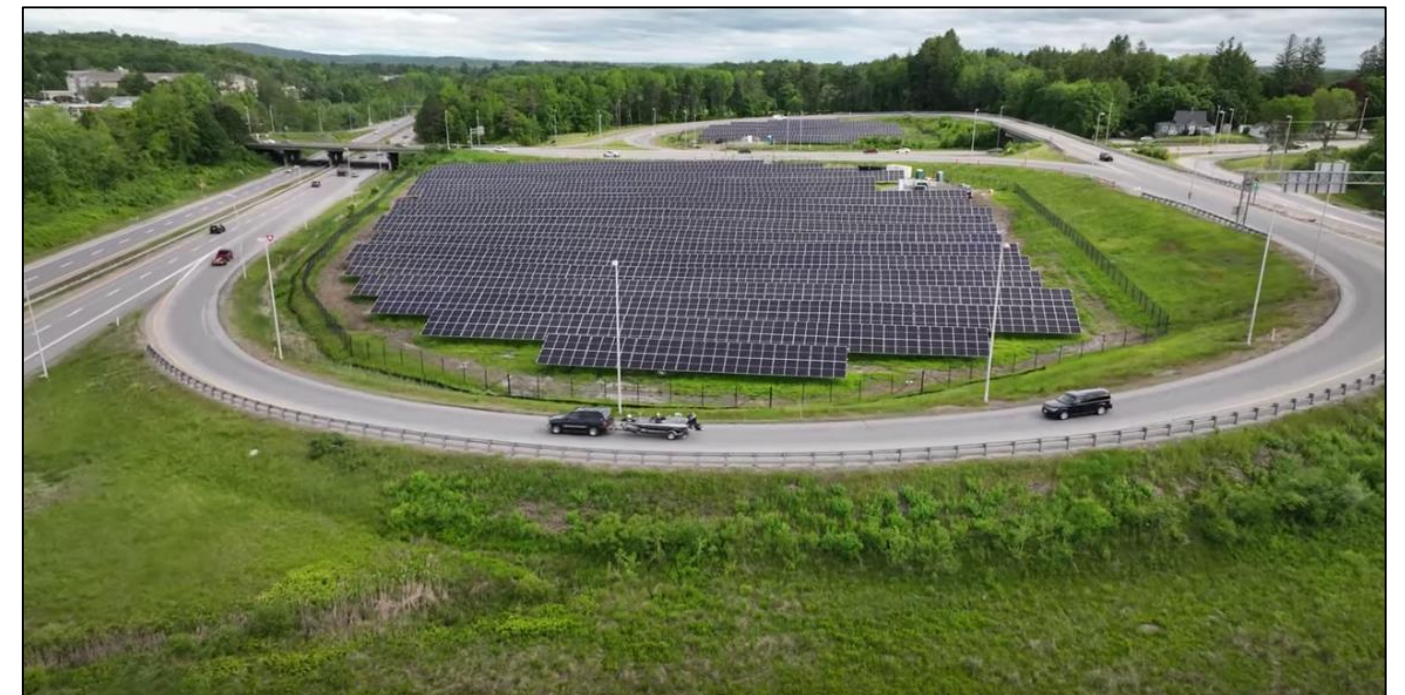
Obrázek 33: FVE situovaná ve vnitřním prostoru smyčky na dálniční mimoúrovňové křižovatce, USA (Maine), Augusta (Zdroj: MaineDOT)
