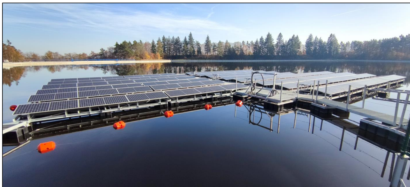
Obrázek 47: První plovoucí fotovoltaická elektrárna v České republice po jejím rozšíření v roce 2023, Štěchovice (Zdroj: Skupina ČEZ)
