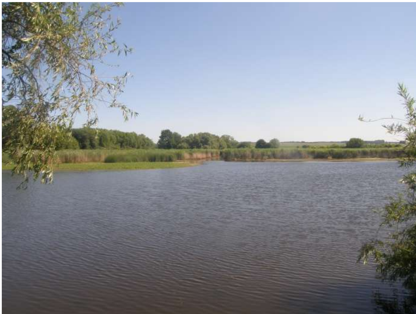
Pohled na rybník z čelní hráze
