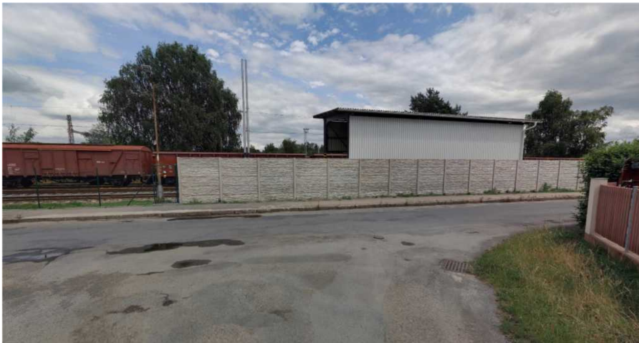
Obrázek 4 - zobrazení nově realizované dělící stěny v prostoru uvažovaného záměru – pohled z ulice Nádražní a Barákova
